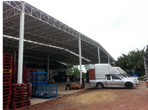
การก่อสร้างต่อเติมพื้นที่ขึ้นสินค้า
